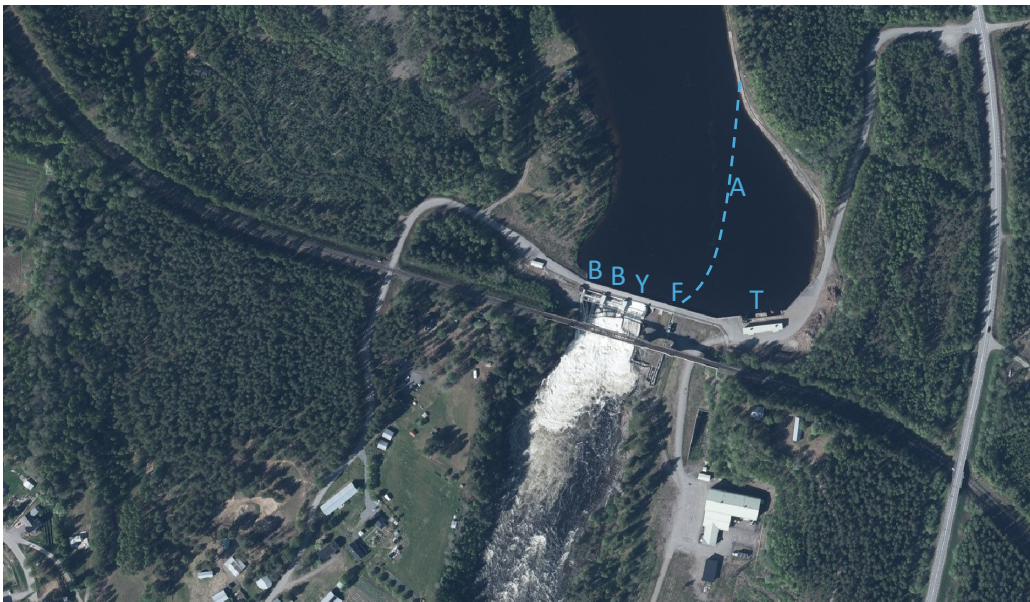
Figur 8. Flygbild över Sikfors kraftverk där avledare och utskov har markerats. A = avledare, B = bottenluckor, Y = ytutskov, F = fiskväg och T = turbinintag.
